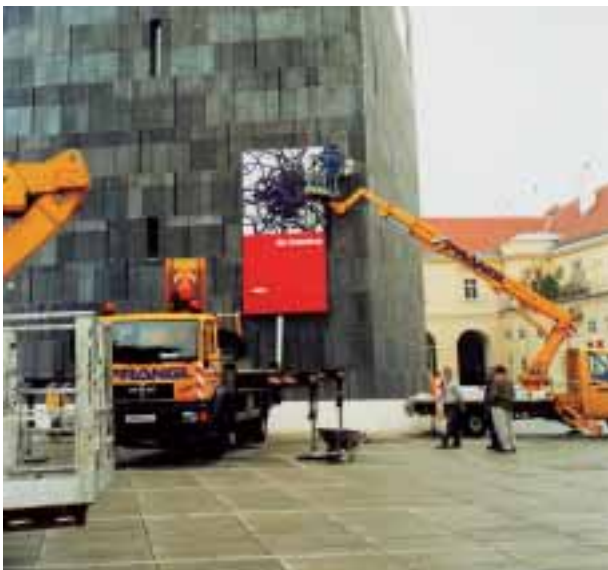
Instalace poutače se Sýkorovým obrazem na fasádě MUMOKu ve Vídni, 2001
